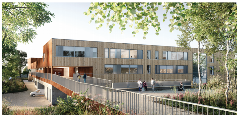
VUE DE L'ENTREE DU CENTRE SPORTIF DEPUIS LA RUE SAINTE ANNE
